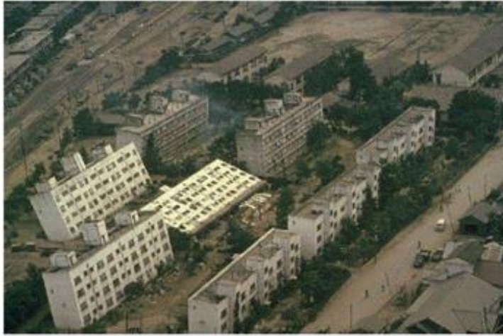
Şekil 5: (solda) 1964 Niigata, Japonya depreminde zemin sıvılaşması nedeniyle binaların çökmesi (fotoğraf: Joseph Penzien), (sağda) Adapazarı Türkiye’de binanın önemli eğimi ile dikey yer değiştirme, 17-8-1999.
