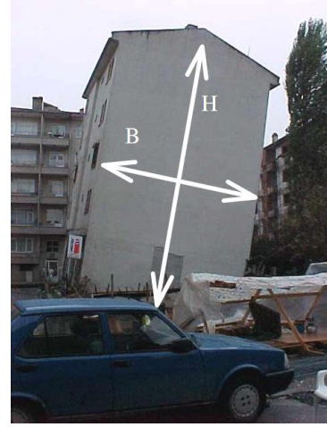
Şekil 5: (solda) 1964 Niigata, Japonya depreminde zemin sıvılaşması nedeniyle binaların çökmesi (fotoğraf: Joseph Penzien), (sağda) Adapazarı Türkiye’de binanın önemli eğimi ile dikey yer değiştirme, 17-8-1999.
