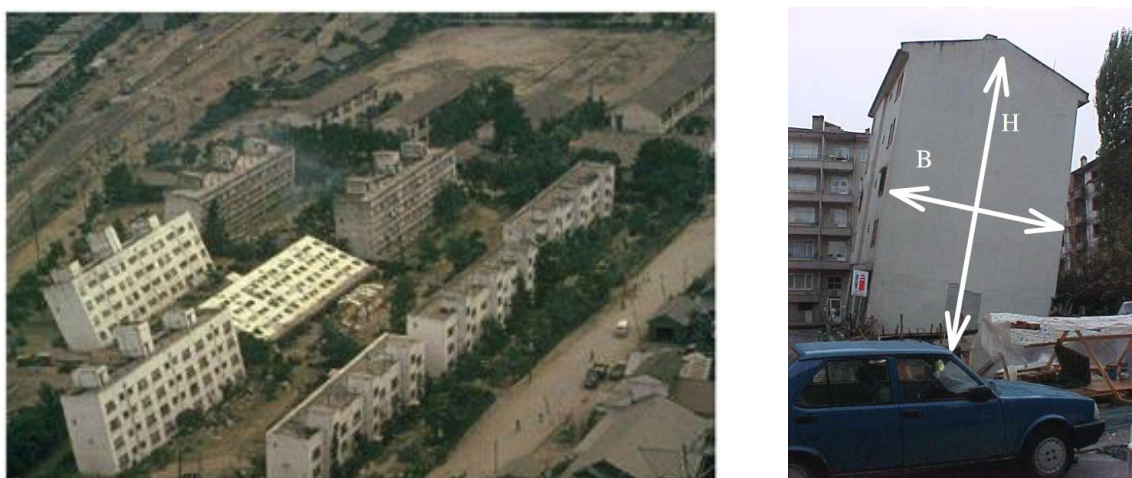
Figură 5 (stânga) Prăbușirea clădirilor din cauza lichefierii solului în timpul cutremurului din 1964 din Niigata, Japonia (foto: Joseph Penzien), (dreapta) Deplasare verticală cu înclinare semnificativă a clădirii din Adapazari Türkiye, 17-8-1999.
