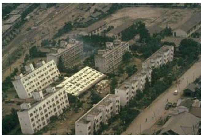
Σχήμα 5: (Αριστερά) Κατάρρευση κτιρίων λόγω ρευστοποίησης εδάφους κατά τη διάρκεια του σεισμού στη Niigata της Ιαπωνίας του 1964 Niigata (φωτογραφία: Joseph Penzien), (δεξιά) κατακόρυφη μετατόπιση με σημαντική κλίση του κτιρίου στο Adarazari της Τουρκίας, 17-8-1999
