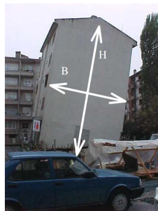
Σχήμα 5: (Αριστερά) Κατάρρευση κτιρίων λόγω ρευστοποίησης εδάφους κατά τη διάρκεια του σεισμού στη Niigata της Ιαπωνίας του 1964 Niigata (φωτογραφία: Joseph Penzien), (δεξιά) κατακόρυφη μετατόπιση με σημαντική κλίση του κτιρίου στο Adarazari της Τουρκίας, 17-8-1999
